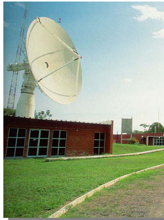
Estação Terrena (Cuiabá)
